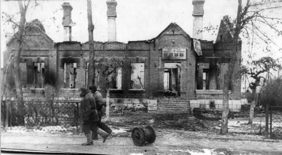
1943 г. Разрушенный и сожженный немецкими оккупантами Клуб железнодорожников в городе Сальске.
